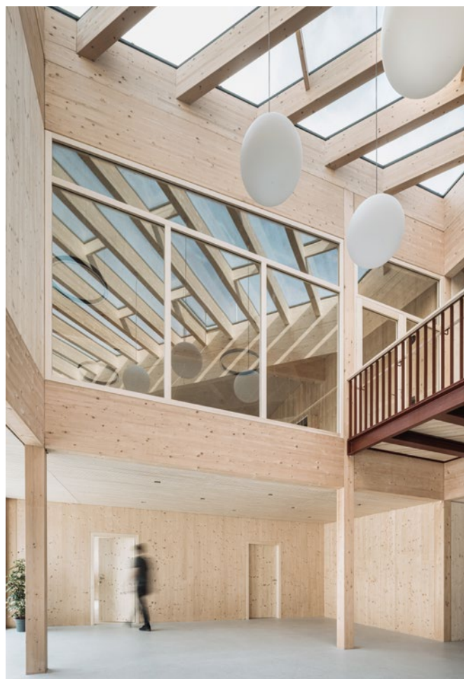
Die Fichte wurde massiv für Wände und Decken eingesetzt. Den Eingangsbereich überspannt ein Fachwerkträger aus Baubuche.
