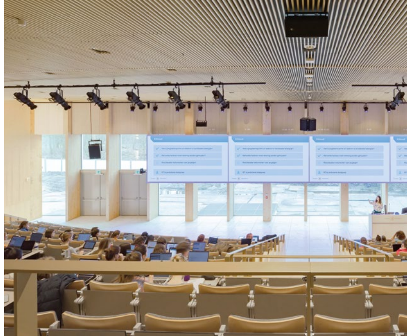
Die akustische Holzgitterdecke zwischen den Balken verbirgt die Technik auf subtile Weise.
