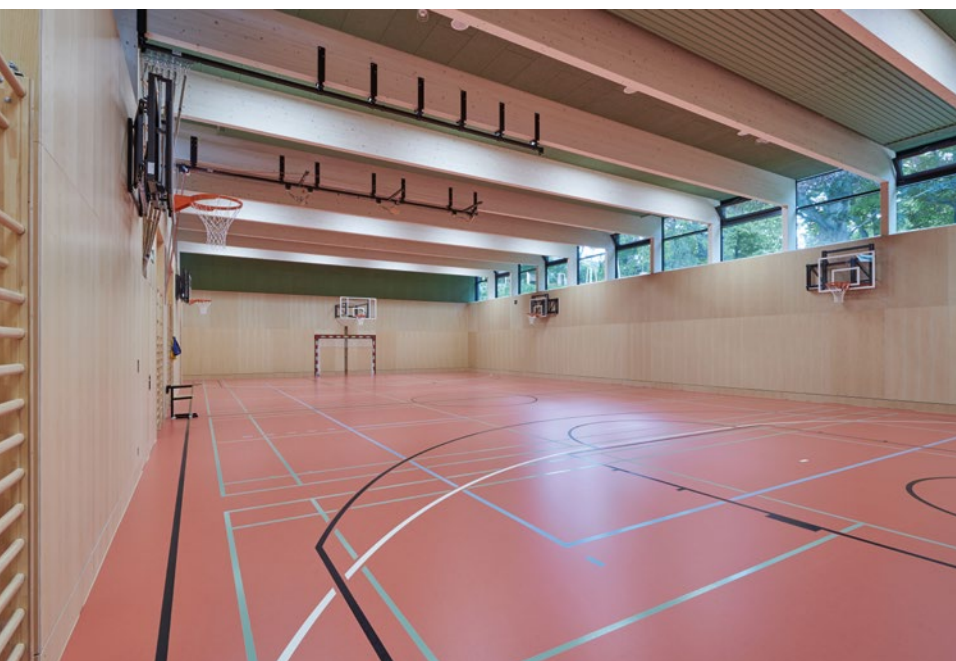
Brettschichtholzträger und Brettspertholzdecken prägen den Innenraum. Wandverkleidungen und Böden aus Esche sorgen für eine warme Atmosphäre.
